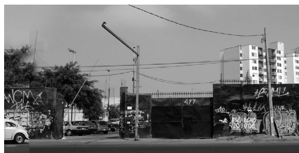
Cerco de un edificio en construcción en av. Colonial, Cercado de Lima.
