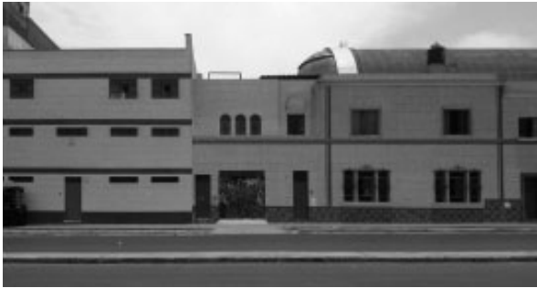
Vista general de fachada en av, Colonial, cuadra 4.
